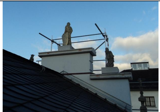
Rückseite Balustrade und Skulpturen FuturBeton
