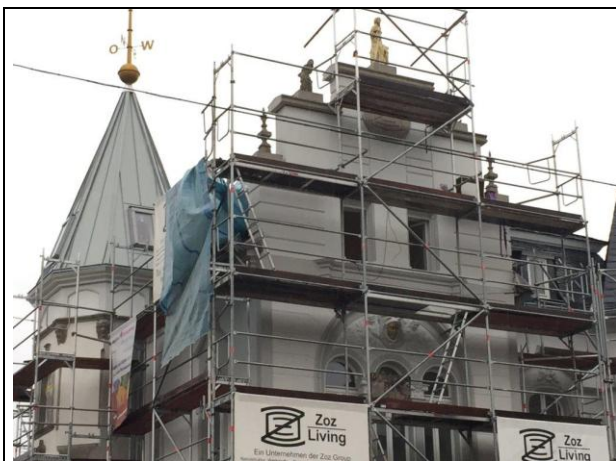
12-Tonnen Balustrade und Skulpturen mit FuturBeton, Turmspitze mit Zentallium® (Zoz-Superleichtbauwerkstoff)
