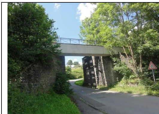
Die Brücke über die Rosenthal Straße in Olpe wird im September ersetzt
